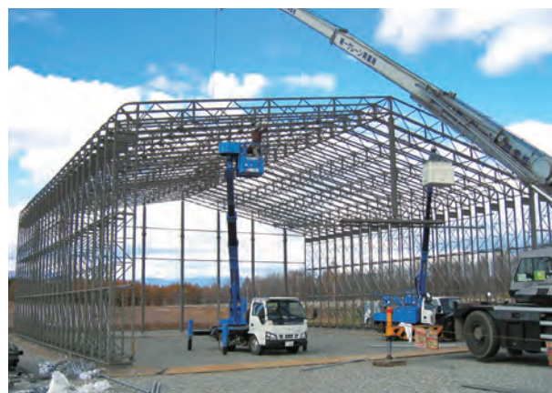
W: 19.5 x L: 20.13 (m) 積雪1m【敷鉄板】施工状況
