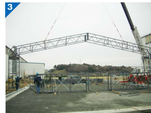
3 固定スパンの地組み・設置
