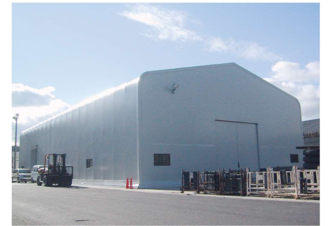
W18m×L35m×H6.6m 積雪 50cm 滋賀県 膜構造建築物
