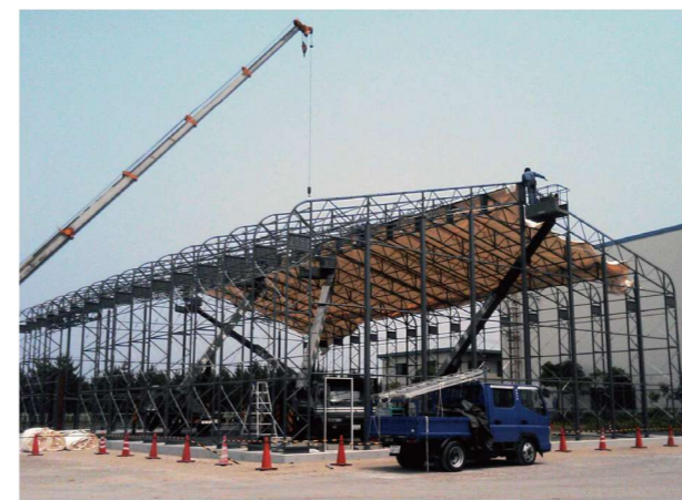
W24.9m×L20m×H5.8m 積雪 30cm 茨城県 膜構造建築物
