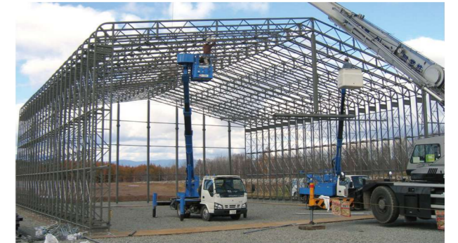
W:19.5m×L:20.13m×H:5m 積雪 1m 仮設ウェイトタイプ (敷鉄板) 施行状況
