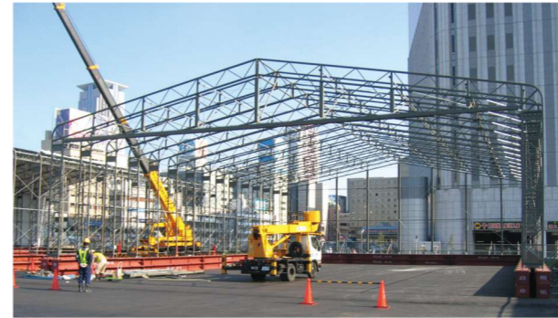
W:19.5m×L:25.62m×H:5.0m 仮設ウェイトタイプ (山留材) 施行状況
