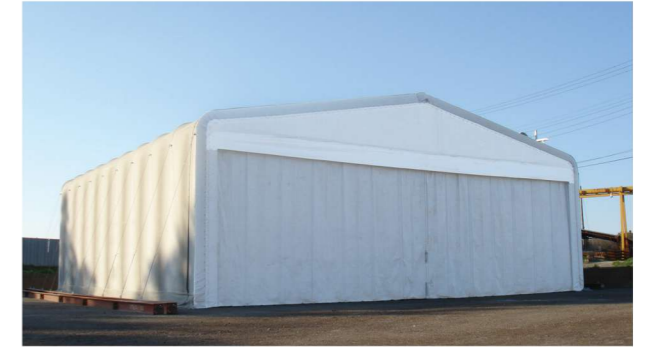
W:16m×L:16.47m×H:4.5m 仮設ウェイトタイプ (山留材) 間口は芯材入りカーテン
