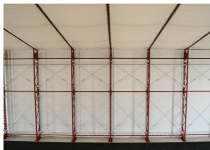
テント内部空間
