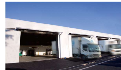
仮設配送センター W23m×L34.6m×H4.6m(有効軒高)
