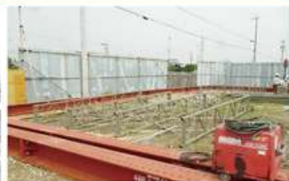
基礎工事が困難な現場は、山留材や敷き鉄板等を基礎代わりとして、設置することも可能です
