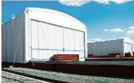
高効率のオリジナル工法
