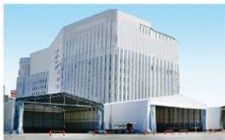
一時的な保管庫や作業場として
