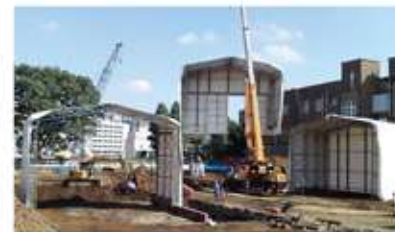
クレーンで持ち上げ、次の作業箇所まで一気に移設します
