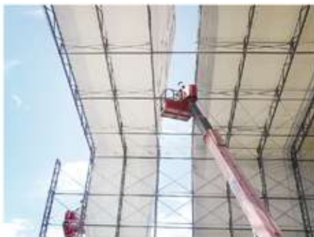
迅速かつ美しい仕上がりに開発した工法
