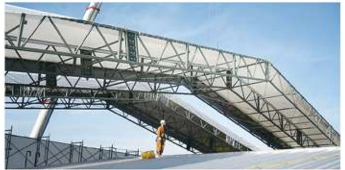
改修工事に最適です
