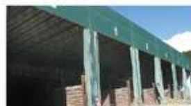
短工期施工に有効です
