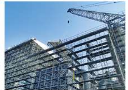
作業性に配慮した構造体
