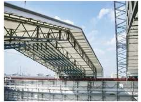
開閉可能な屋根部
