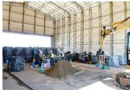
中柱の無い明るい大空間
