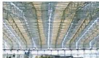
ユニットごとのテント屋根部
