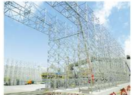
大型重機の作業に適した軒高の高いテント
