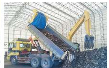
災害瓦礫処理テント
