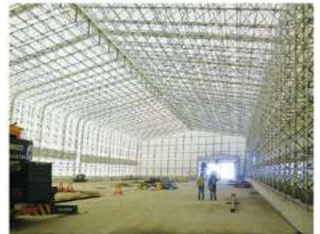
中柱の無い明るい大空間
