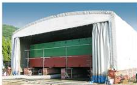
資機材保管テント
