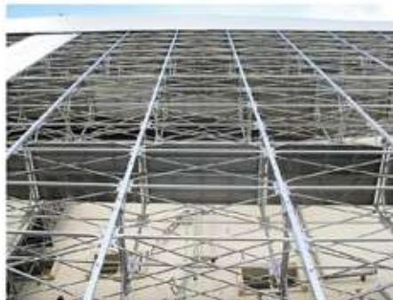
高効率のオリジナル工法
