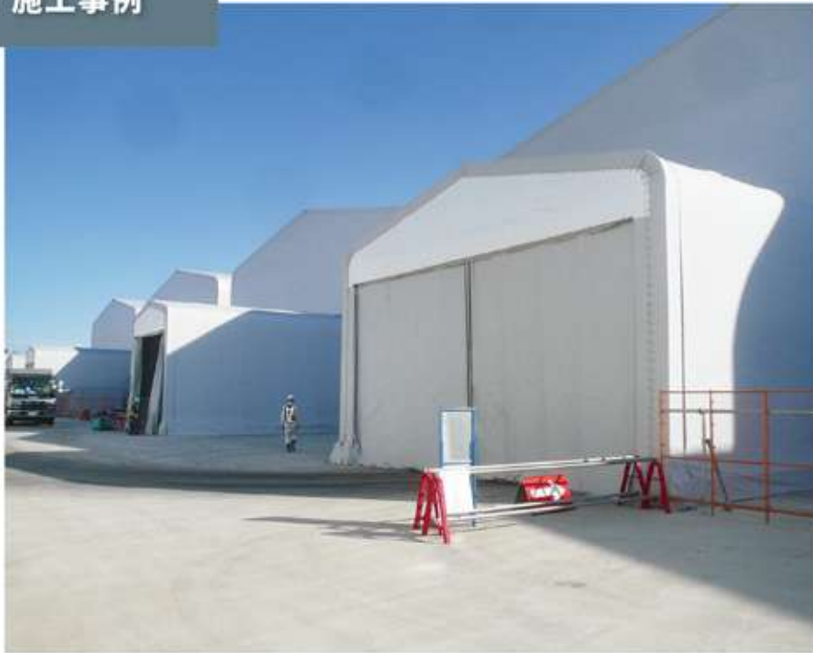
前室を設けた土壌改良工事に用テント
