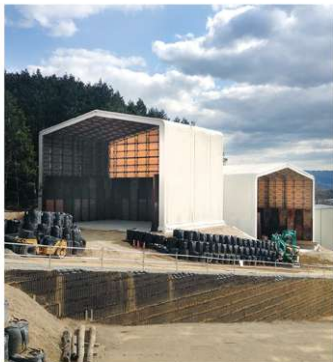
トンネル工事におけるスリ置場用テント
