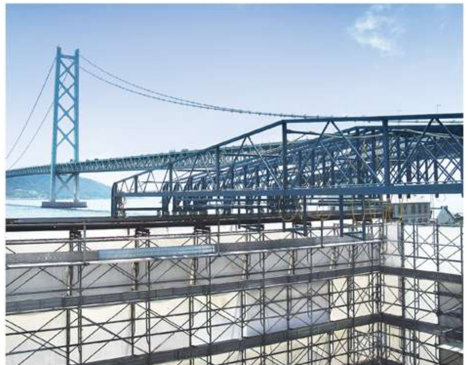
桁組足場に伸縮式の屋根部を設置した工法
