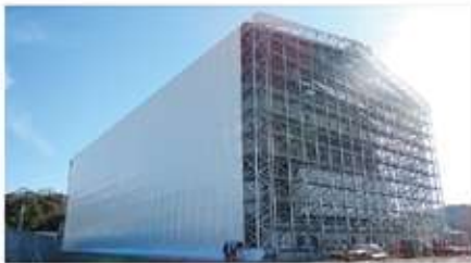
フレームに足場が備わった、一体式の構造体は自社開発した、安心して安全の構造体です
