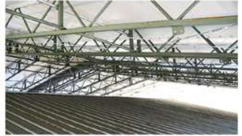
天候にかかわらず改修工事が行えます
