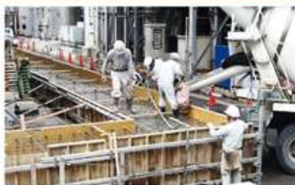
コンクリート基礎工事
