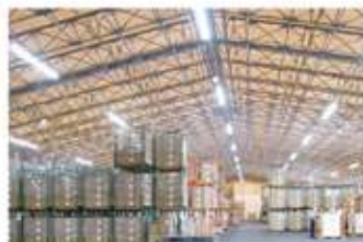
中柱の無い明るい大空間
