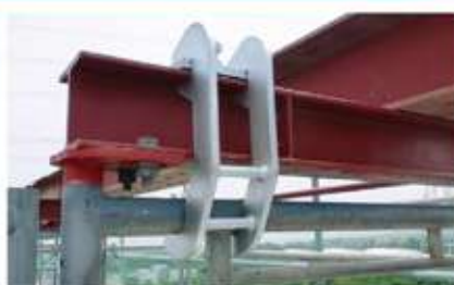
足場と大引きを強固に固定する、専用金具
