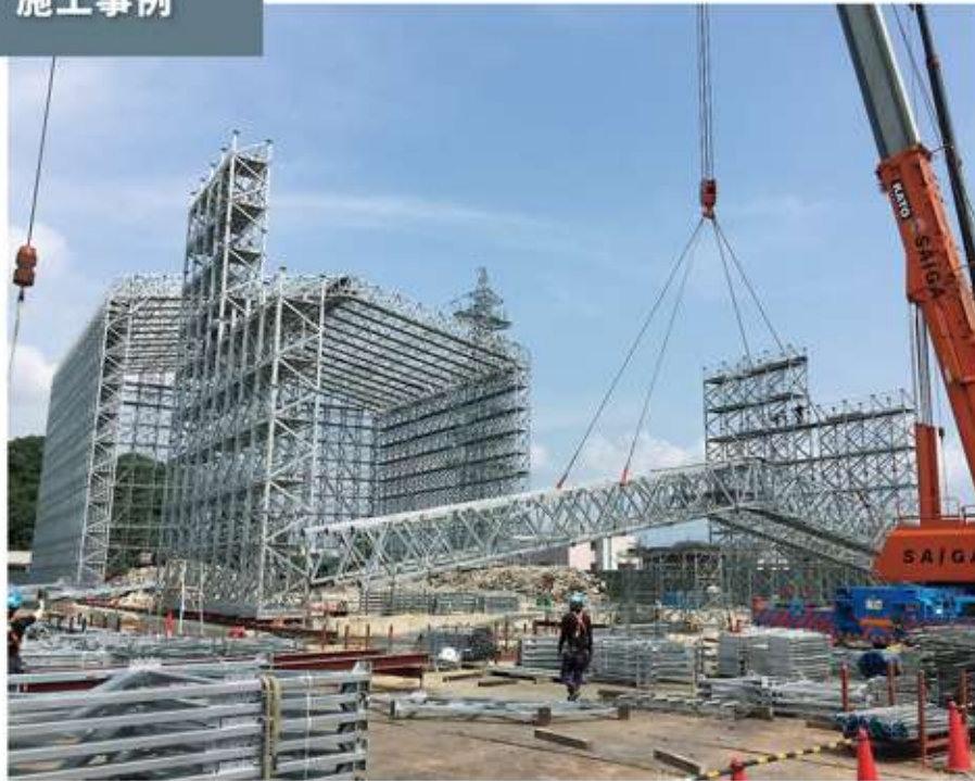
飛散防止対策や工事に伴う騒音の抑制対策として有効です
