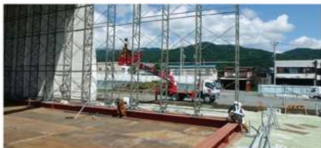
山留材基礎と敷鉄板基礎
