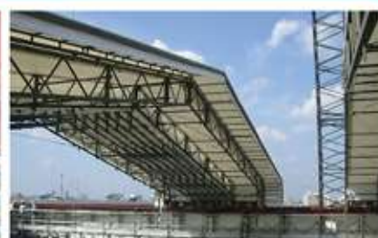
伸縮式上屋フレームを使用することで、屋根部の開閉が可能な仕様とすることもできます
