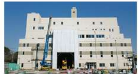
建築物内部の解体工事における、前室テントカバー
