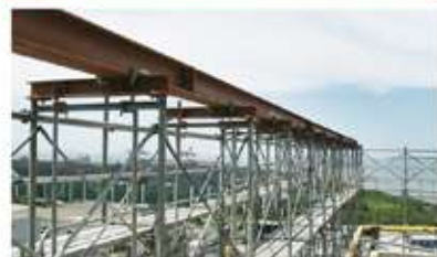
足場上に設置されたレール
