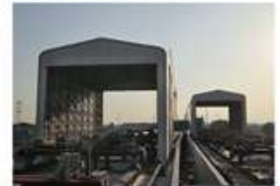
短工期施工に有効です
