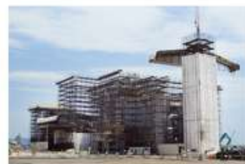
短工期施工に有効です
