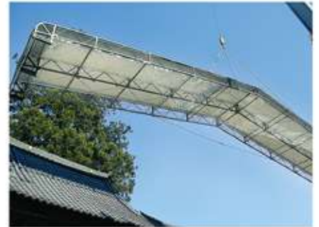
高効率のオリジナル工法
