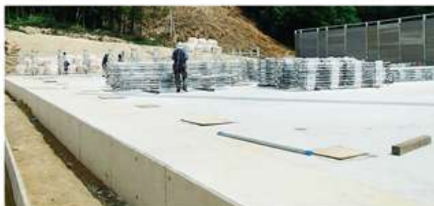
コンクリート基礎
