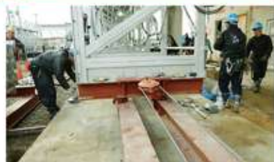
ウインチによる送り込み作業
